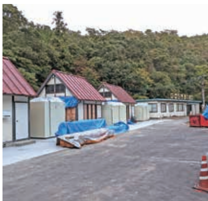
新ジビエ加工施設（建設中）
