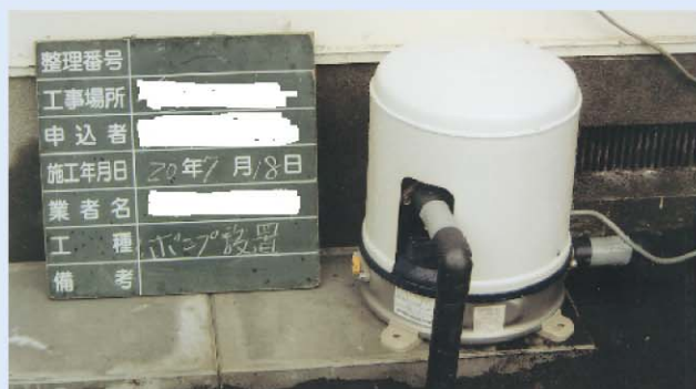
6.水中ポンプ設置
