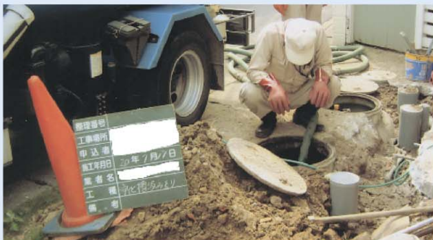
1.浄化槽汲取り
