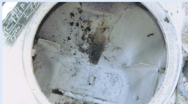
2.浄化槽解体施工
