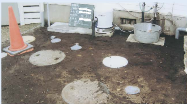
7.雨水貯留槽 完成
