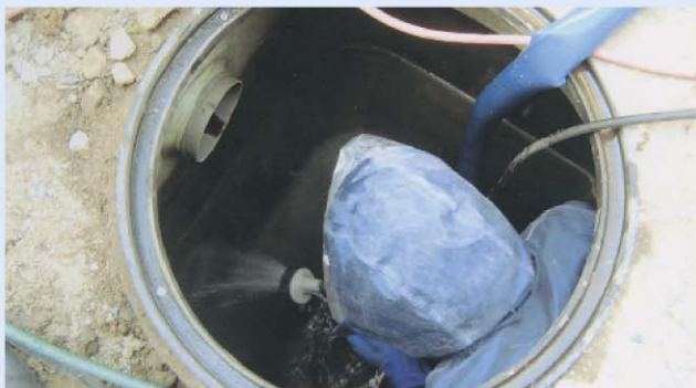
3.浄化槽内清掃
