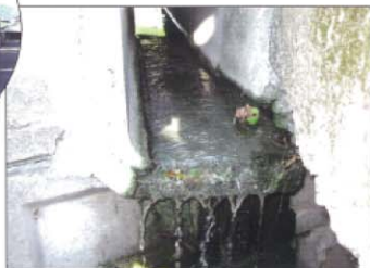
1970年代 単独処理浄化槽設置地域の側溝の例 (白っぽいヘドロ状のものが堆積しています)
