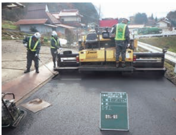
舗装修繕工事
