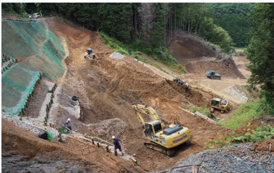
復旧作業の進む広域農道
