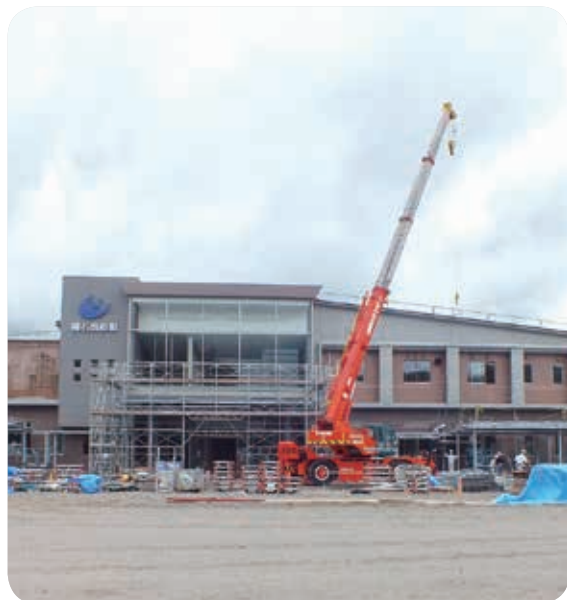
完成間近の新庁舎建設
