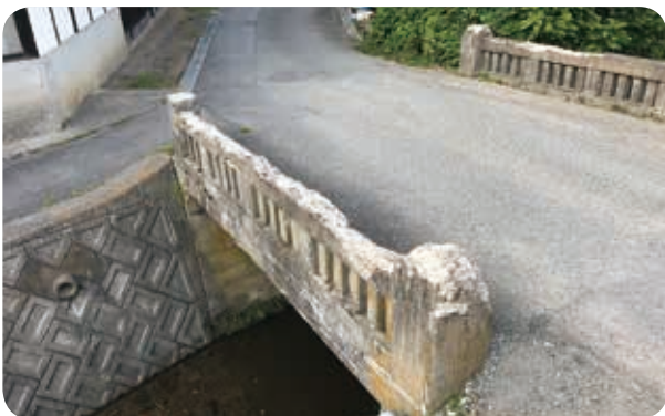
修繕が必要な橋
