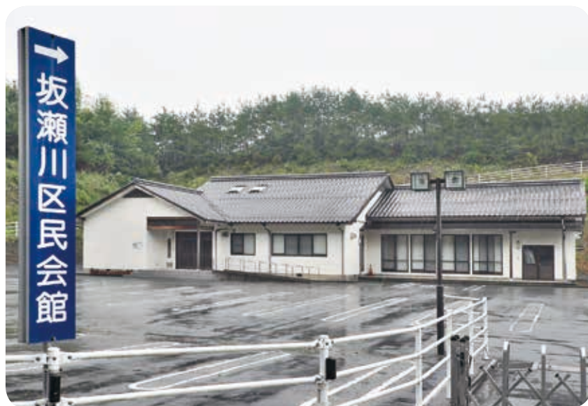
避難施設から除外された坂瀬川区民会館
