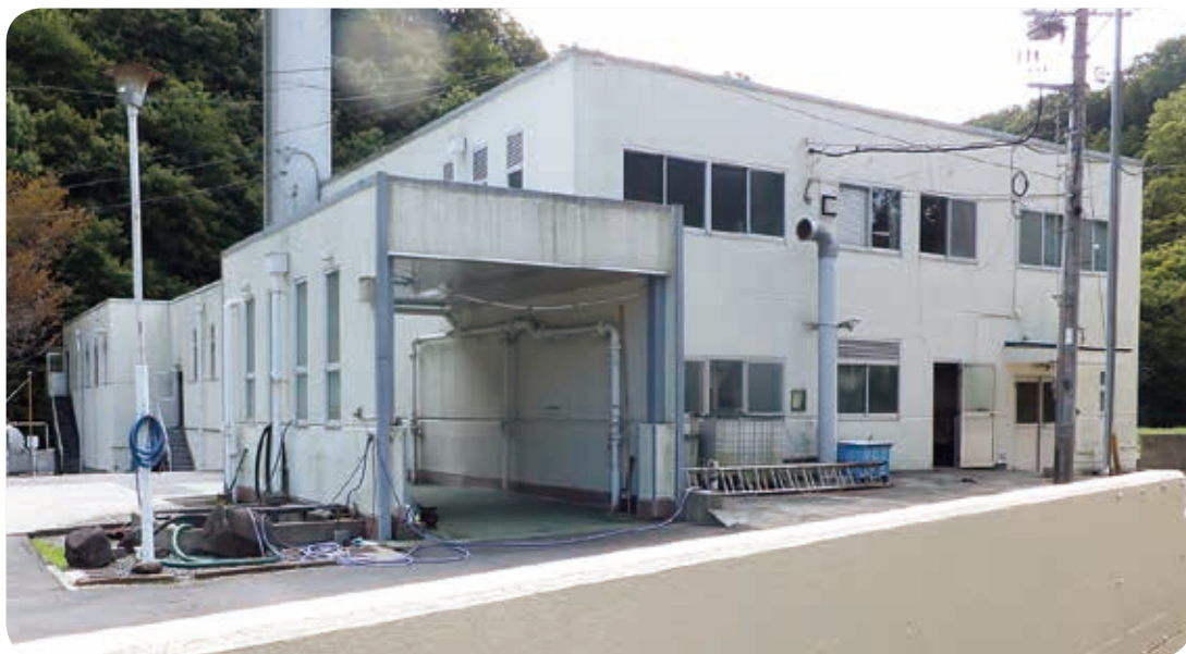
昭和54年稼働の神石郡し尿処理場
