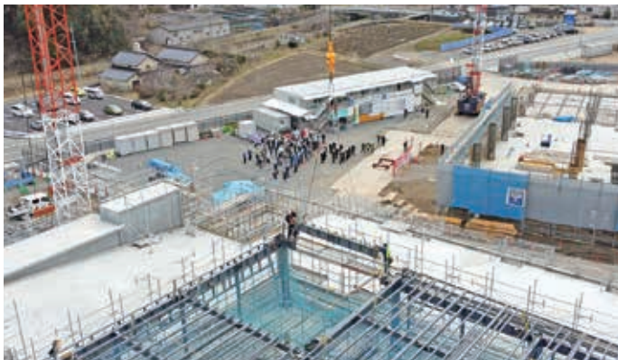
※梁揚之儀 （鉄骨梁を取り付ける様子）
