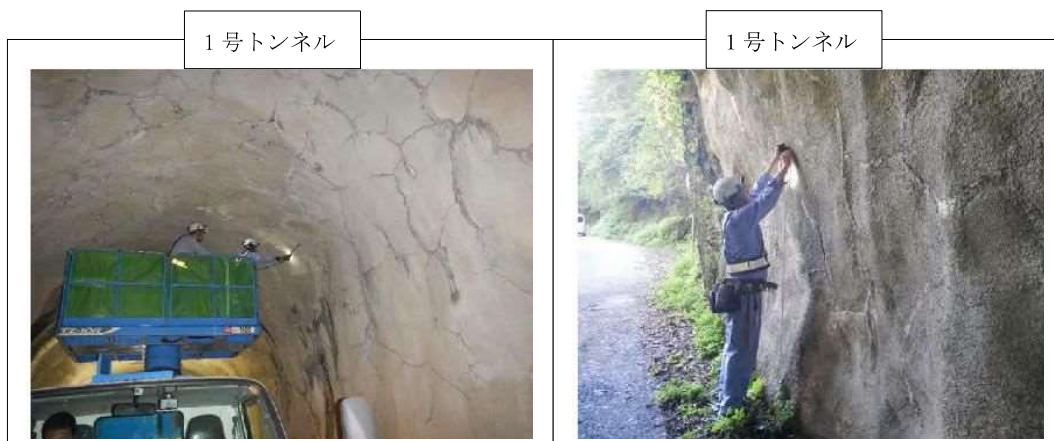
図 1-3 トンネル定期点検状況（平成 30 年度）
