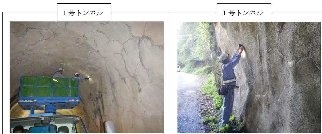
図1-3 トンネル定期点検状況（平成30年度）
