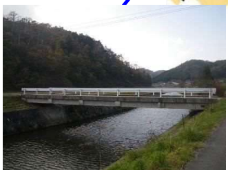
妙見橋 L=21.0m(PC橋) 1991 年架設
