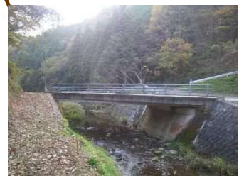
小田橋 L=17.4m(PC橋) 1989 年架設
