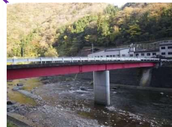
仁滝橋 L=54.5m(鋼橋) 1986 年架設
