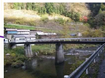
手入橋 L=56.4m(鋼橋) 1973 年架設
