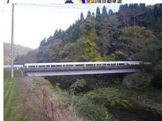
昭十橋 L=22.4m(PC橋) 1983 年架設
