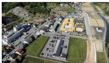
〈ドローンで撮影した庁舎建設予定地〉
