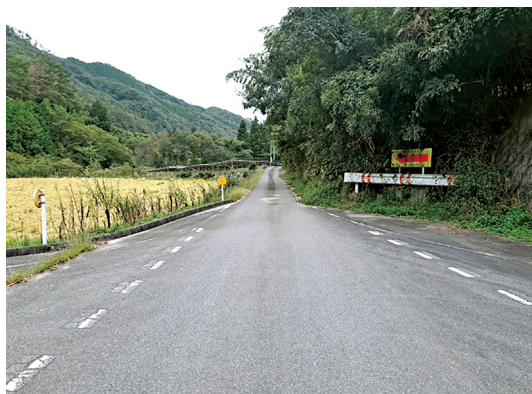
幅員が狭くなる、県道三和油木線 安田工区（阿下・安田間）
