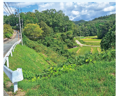
地すべり対策工事
