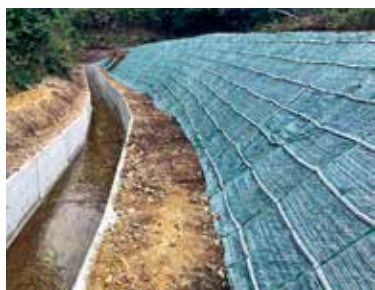
小規模崩壊地復旧事業（木津和地区）
