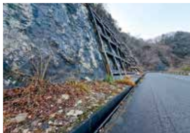
災害の兆候を把握し 被害防止に努める 広域農道 法面調査
